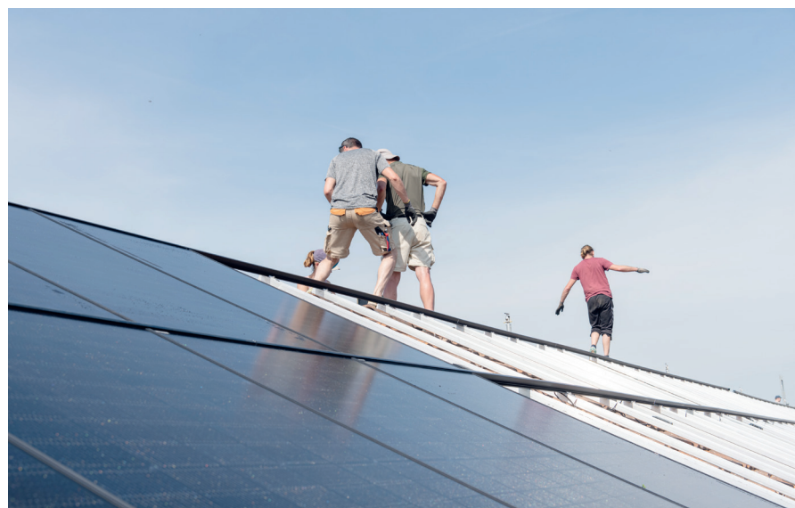
Schritt für Schritt zur Energiegewinnung: An der Frühlingsoffensive 2023 wurden mit den Wohnhäusern an der Talgutstrasse 63–69 und Zwinglistrasse 24–30 die letzten Talgut-Dächer mit Solaranlagen ausgestattet. Bilder: Elisabeth Egli.
